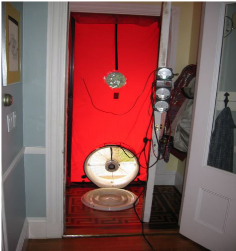
Blower Door Set-Up
